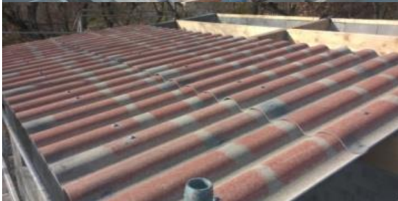
Construction d'un garage pour la commune de Mallemoisson (2015-2016)
