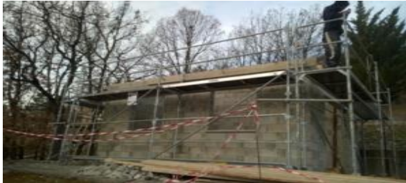
Construction d'un garage pour la commune de Mallemoisson (2015-2016)
